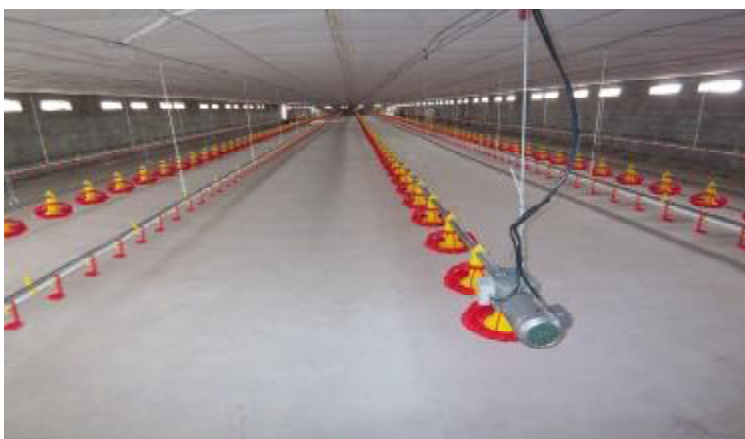
水、料线安装现场
