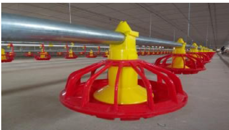
料现安装现场
